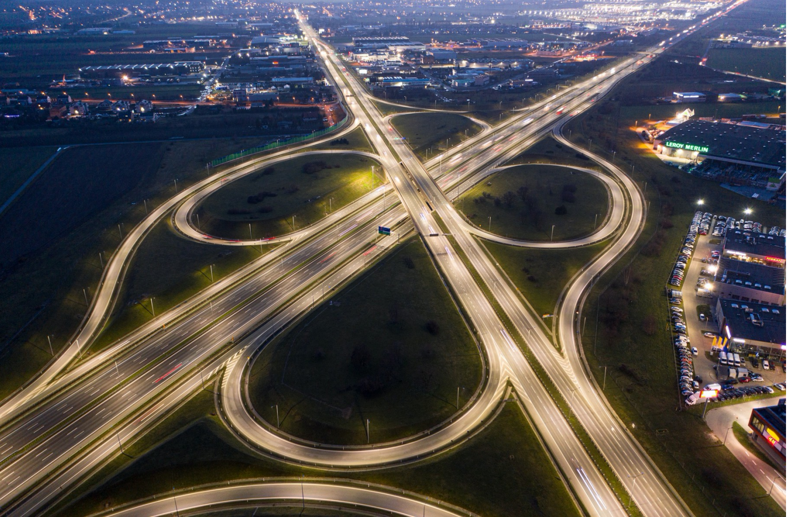
Poznań. Autostrada A2 oświetlona produktami marki LUG (fot. archiwum firmy LUG)
